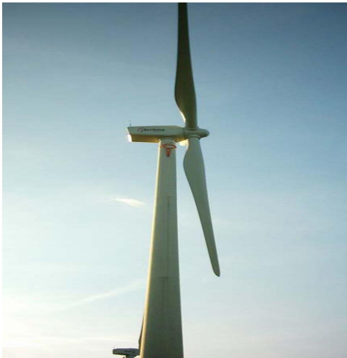
Figura 2 Prototipo construido en Aibar
